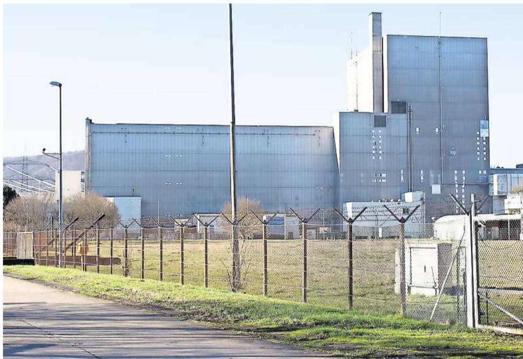
Laut Gutachten ungeeignet als Bereitstellungslager für schwach- und mittelradioaktiven Abfall: Das ehemalige Kernkraftwerk Würgassen.
